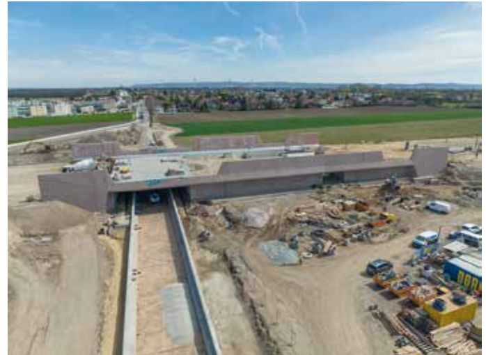
Der künftige Bahnhof Ebreichsdorf samt Unterführung der L150 im Entstehen. Foto: ÖBB/studiobaff.com
